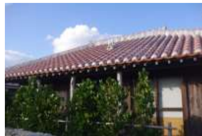
写真上) 多用途住宅は、空きがあり、綺麗に手入れされていました。
